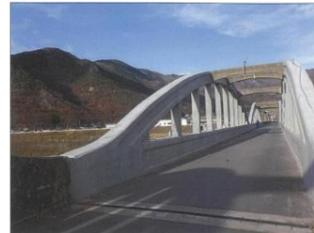
(写真上-令和3年度完成、RCローゼ橋、P4-P5間主構補修下-令和3年度完成RCローゼ橋、P3-P5間主構補修)
