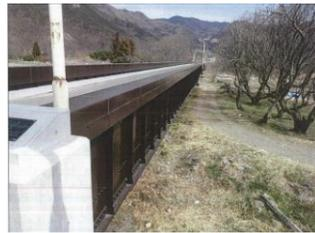
(写真上-平成30年度完成 鋼製ゲルバーガーター橋、上流側左岸橋台より下-上流側A2橋台より)
