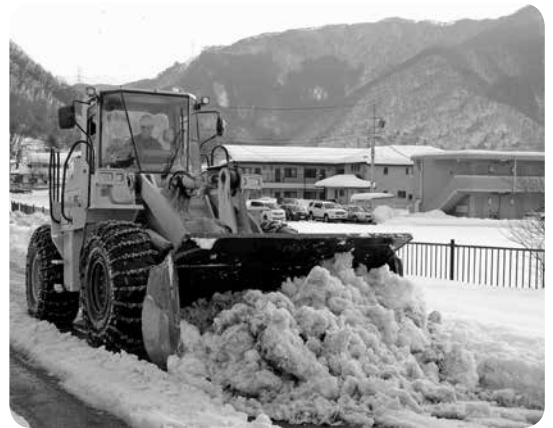
平成26年 大雪の際の除雪作業
