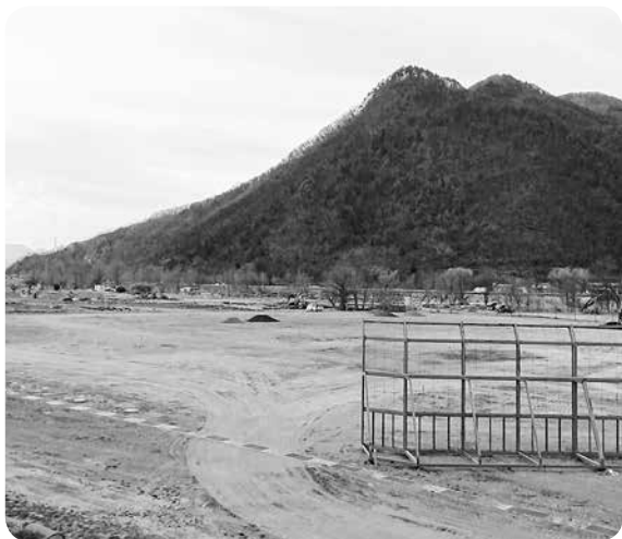
災害復旧工事が進む上五明運動公園
