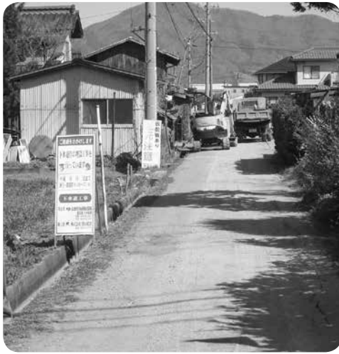
下水道工事（新地）
