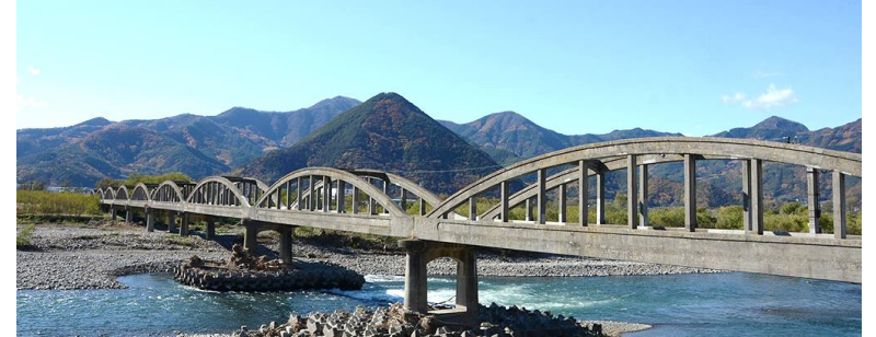
昭和橋の長寿命化・修繕
