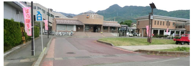
テクノさかき駅前の舗装修繕 バリアフリー化工事を計画 （R2～R3）
