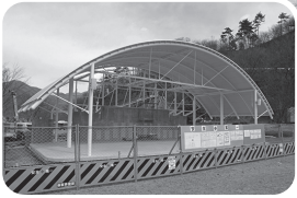
◀工事中の様子
