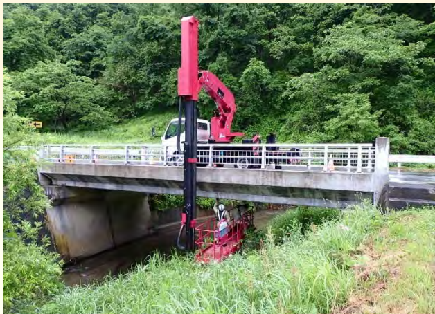
橋梁点検車による点検
