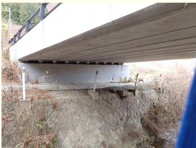
健全度Ⅰ：坂城町 170 号橋
