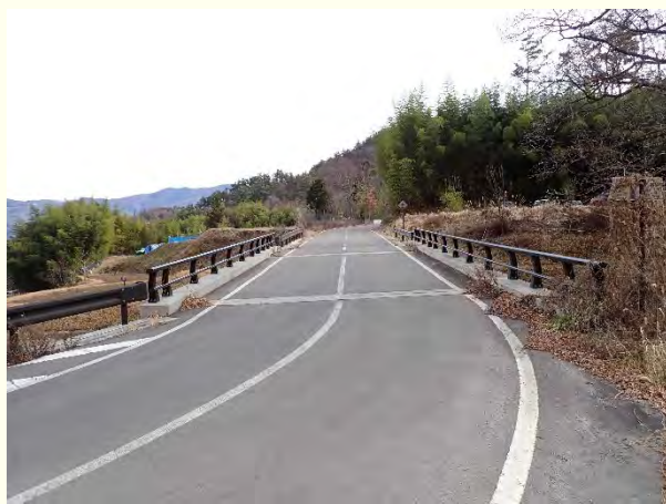
坂城町 170 号橋 (橋面より)
