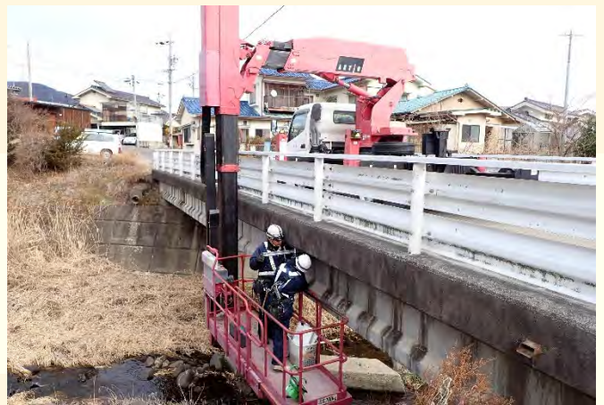
橋梁点検車による点検
