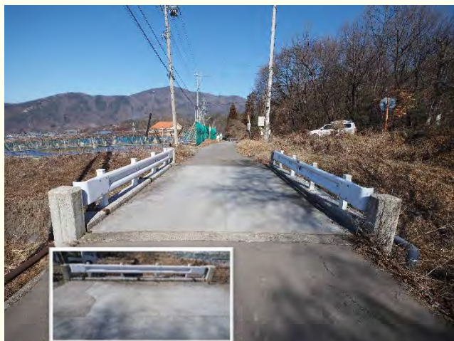
坂城町 083 号橋 (橋面より)
