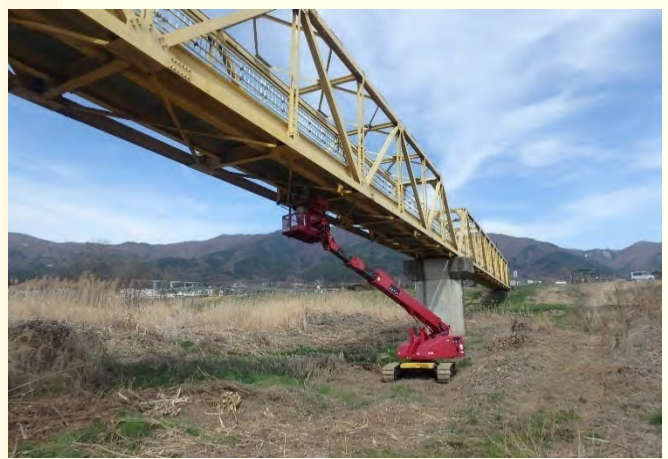
高所作業車による点検
