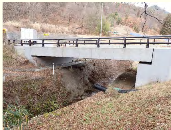
坂城町 170 号橋 (側面より)
