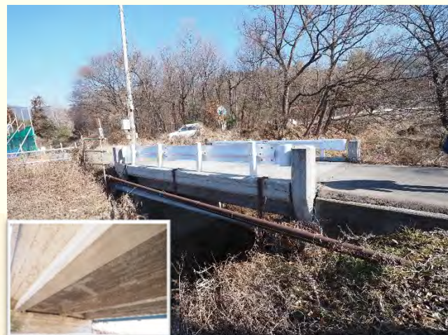
坂城町 083 号橋 (側面より)
