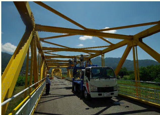
高所作業車による点検
