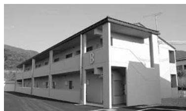
◀町営住宅 中之条団地 (竣工当時)
