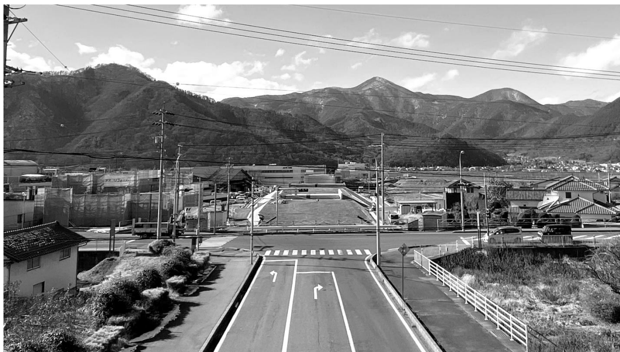
延伸の進む主要地方道坂城インター線
