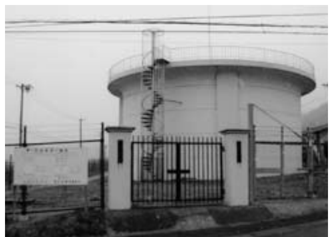
県営水道の中之条配水池
