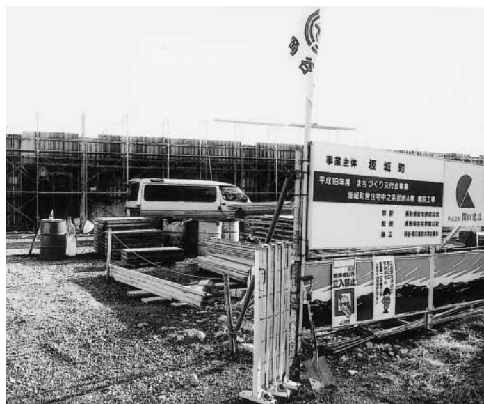
建設進む中之条住宅団地
