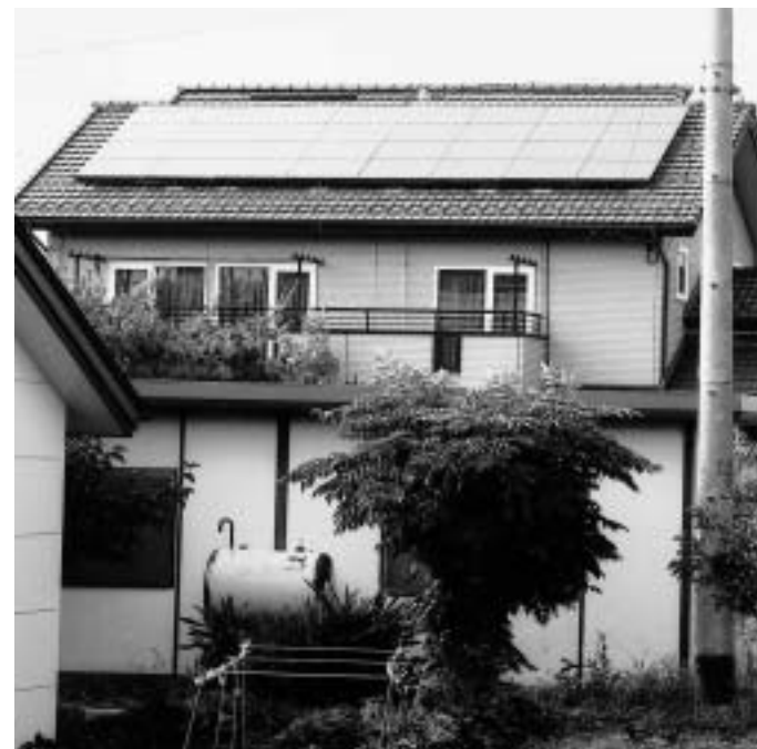
自然エネルギーの活用 太陽光発電
