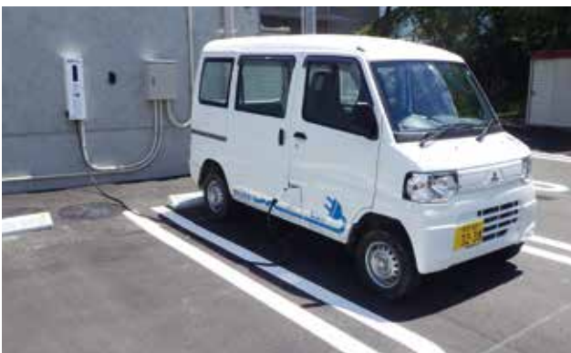
文化センター 電気自動車充電器
