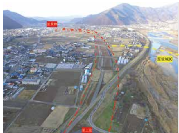
工事が進む国道18号バイパス
