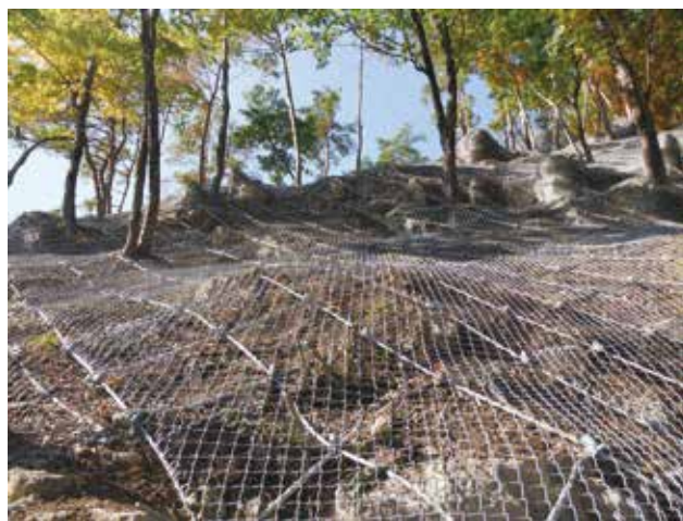
大宮地区ロープ伏工
