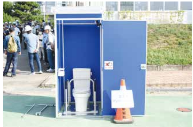
マンホールトイレ
