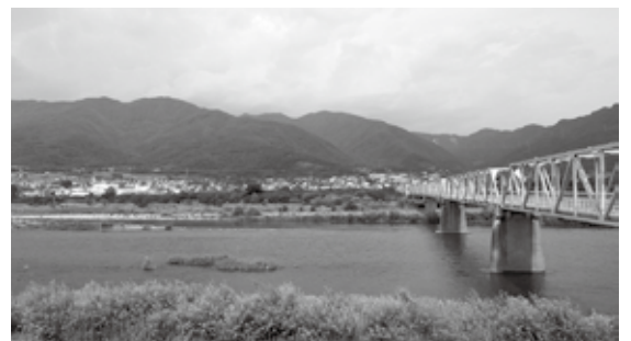
【写真4】開畝製鉄遺跡遠景
