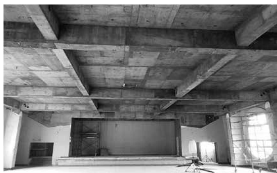
⑦ 改修中の大会議室
