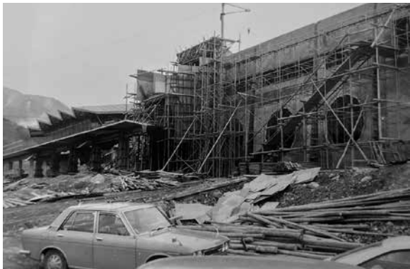
①文化センター建設の様子
