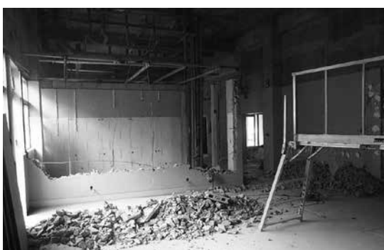
⑧ 改修中の2階の様子
