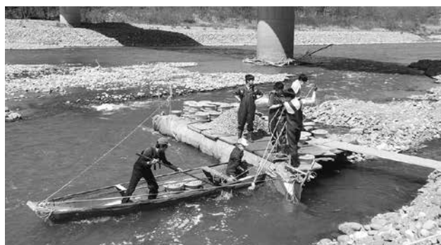
手入れ作業の様子
