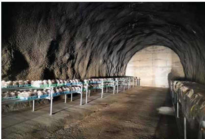
五里ヶ峰トンネルの横坑。きのこのホダ木が並ぶ
