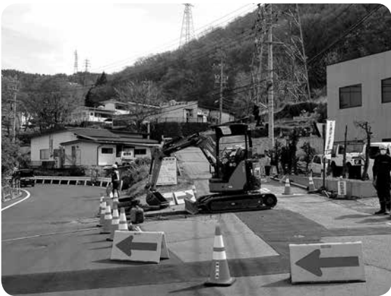
下水道工事（鼠団地入口）
