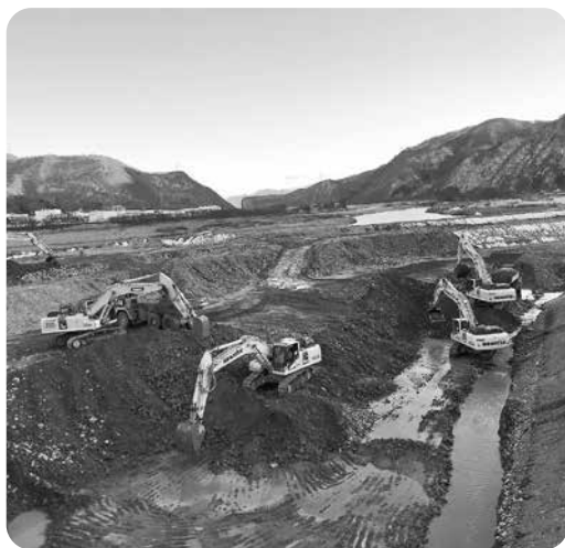
災害復旧工事(大望橋左岸)
