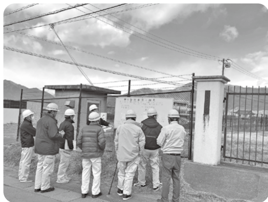
中之条配水池
