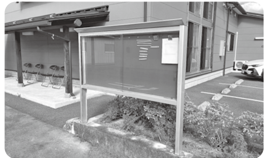
移転した南条掲示場
