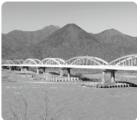
修繕が進む昭和橋
