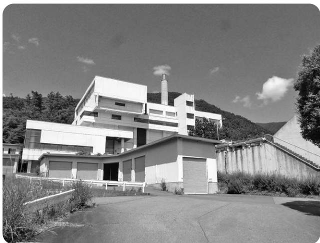
現施設を解体し、新リサイクルセンターを整備
