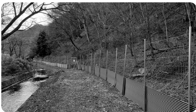
完成間近の有害獣侵入防止柵（網掛地区）
