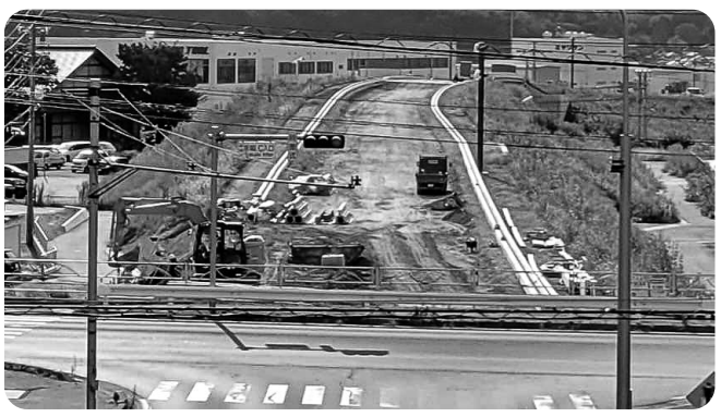
工事が進むインター線 先線
