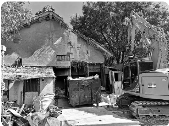
解体工事中の旧兒玉邸
