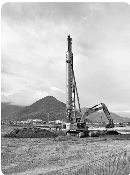
地盤改良工事をしている超大型機械（バイパス予定地）
