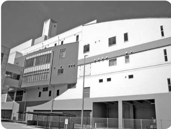
本稼働した「ちくま環境エネルギーセンター」
