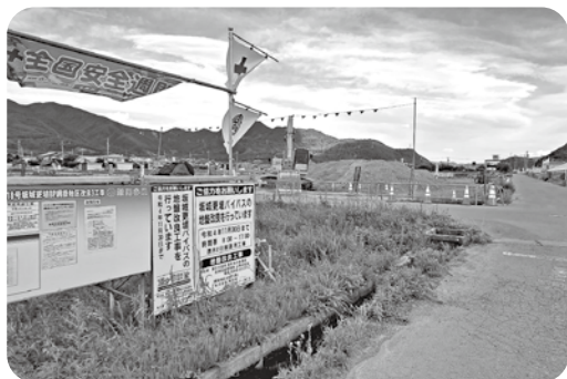
18号バイパス工事（上五明）
