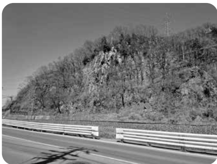
落石対策工事を予定（荇屋原）
