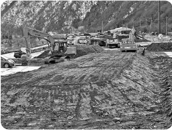
バイパス工事が始まる(網掛地区)
