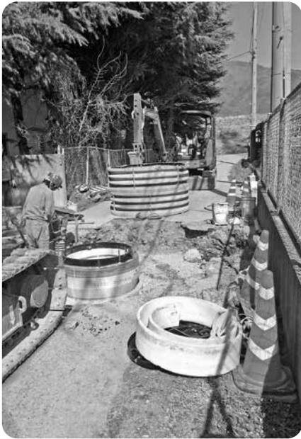
下水道工事(月見)
