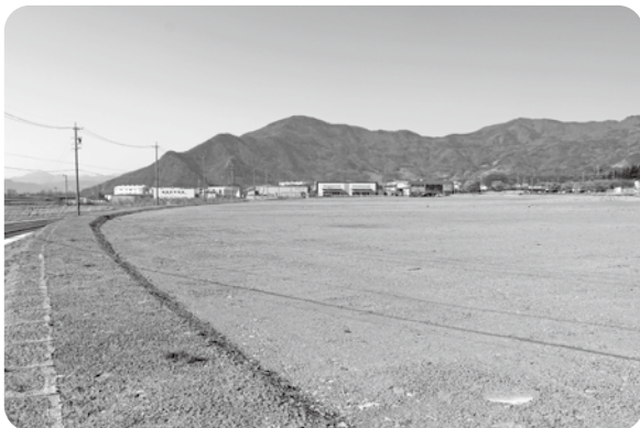
完成した南条産業団地
