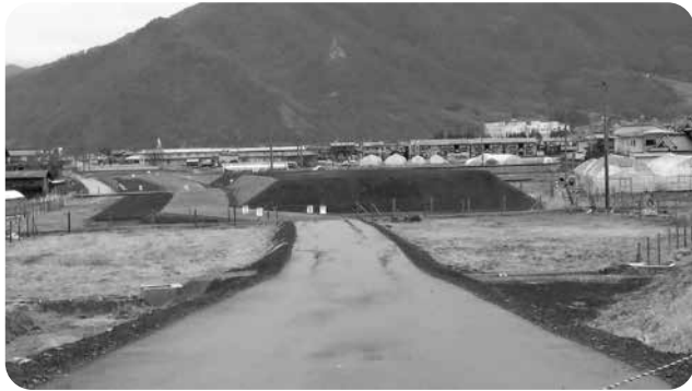
国道18号バイパス工事（網掛地区）
