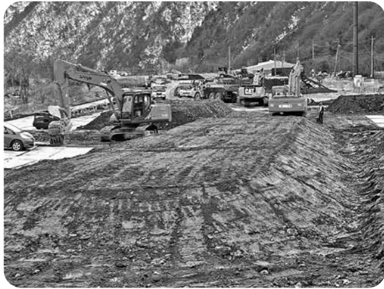
バイパス工事が始まる（網掛地区）
