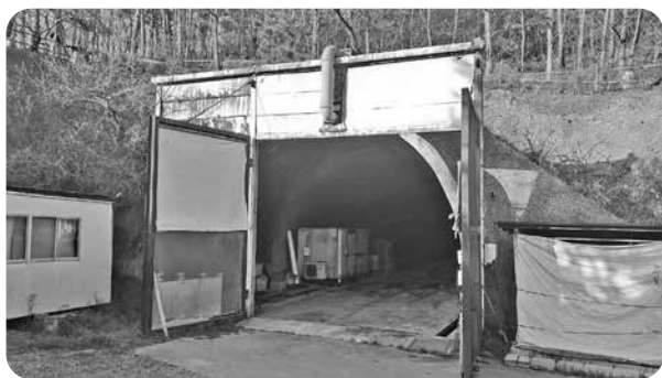
五里ヶ峰横坑作業用トンネル 坑口
