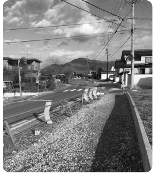
拡幅工事が進む産業道路（南条）
