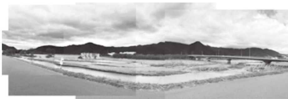
写真 10 令和元年東日本台風による被害（左に坂城頭首工、右に坂城大橋）
