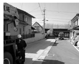
8:50 クレーンのケーブルで引っ張る
