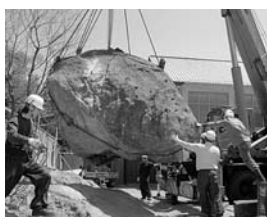
11:00 クレーンで持ち上げる!
