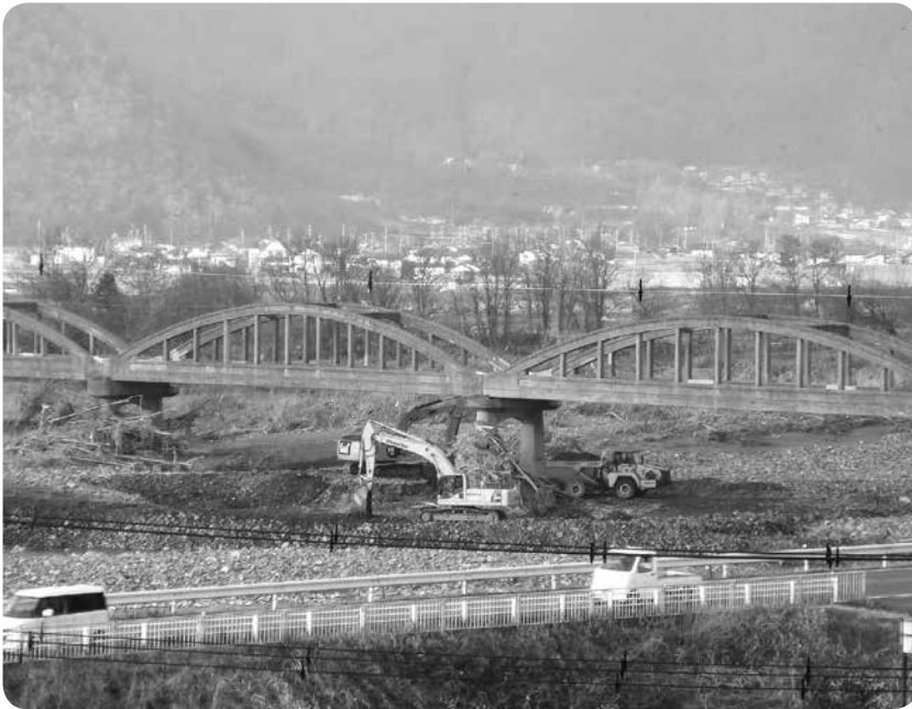
洗掘された橋脚の復旧工事（土木遺産 昭和橋）
