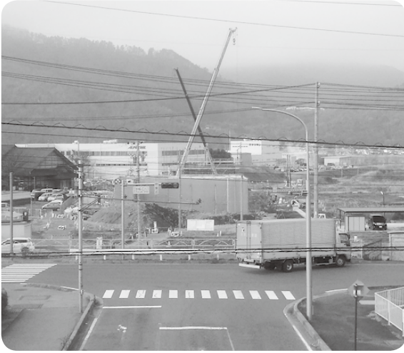
県道坂城インター線の先線工事
