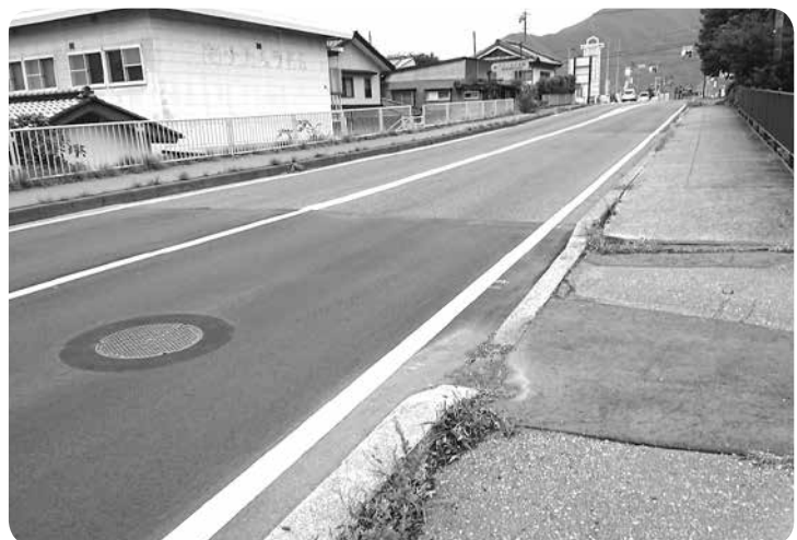
下水道管理設終了(国道18号線金井地区)
