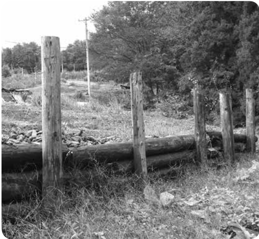
有線柱の再利用
