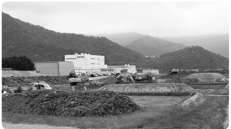
インター先線工事始まる
