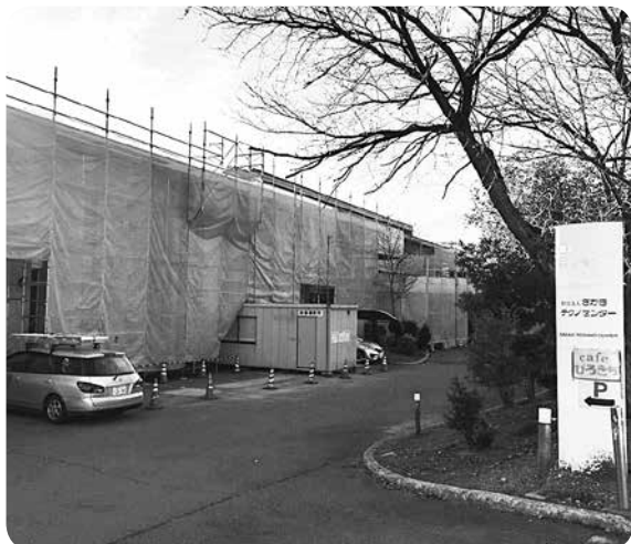
改修工事が進む坂城テクノセンター
