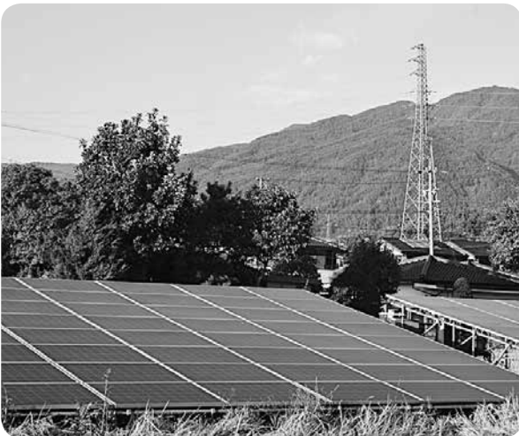
設置が進む太陽光パネル
